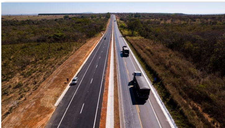
Eco135 Duplicação da rodovia
