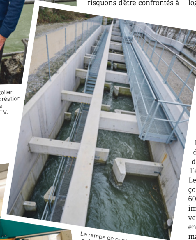
La rampe de passage des poissons serpente à travers la construction en béton de l'ouvrage d'entrée du barrage.
