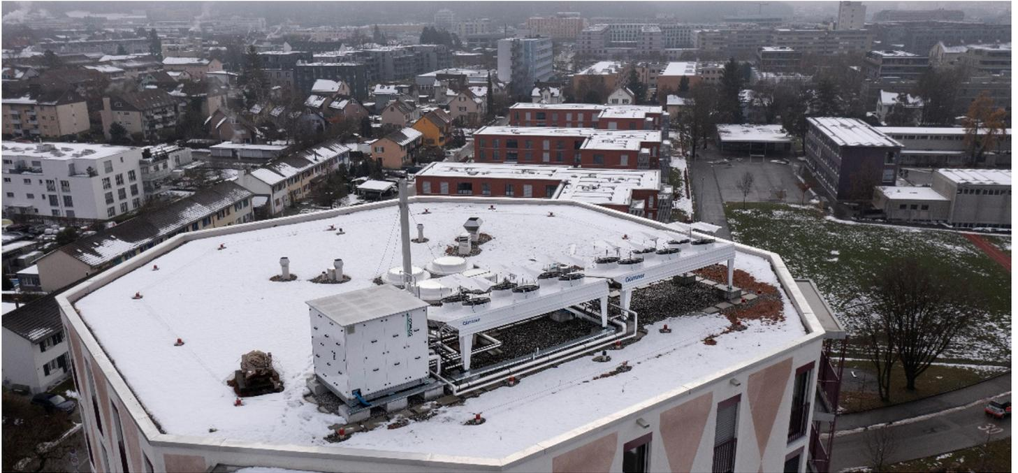
Eines der Beispiele, wo eine Holzheizung mit einer Wärmepumpe kombiniert wird: Auf dem Hobelwerk-Areal in Winterthur (Baulos 2) deckt seit 2022 eine Luft-Wasser-Wärmepumpe (225 kW) den Grundbedarf für Heizung und Warmwasser. Bei grösserem Wärmebedarf kommt zusätzlich eine Pelletheizung (200 kW) zum Einsatz. Foto: Scheco AG
