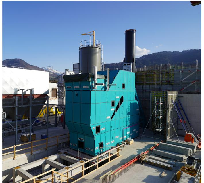
Die Energie Ausserschwyz AG baut seit 2021 am Zürichsee zwischen Wollerau und Siebnen schrittweise ein Fernwärmenetz auf. Die Wärme stammt aus einem Holzheizkraftwerk, das bis anhin zu 60 % mit Altholz befeuert wird, und einer Biogasanlage. Die Holzfeuerung (Bild: beim Einbau) ist für die Verbrennung von bis zu 90 % Altholz ausgelegt. Foto: Energie Ausserschwyz AG
