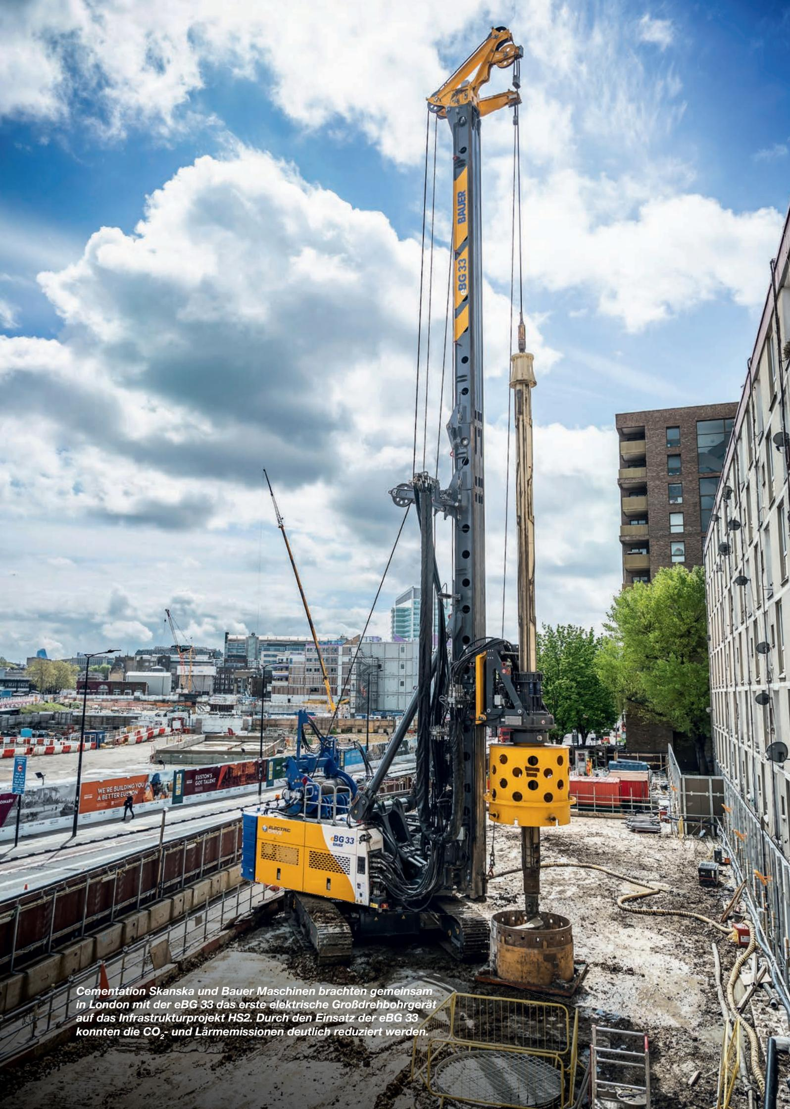
*Cementation Skanska und Bauer Maschinen brachten gemeinsam in London mit der eBG 33 das erste elektrische Großdrehbohrgerät auf das Infrastrukturprojekt HS2. Durch den Einsatz der eBG 33 konnten die CO<sub>2</sub>- und Lärmemissionen deutlich reduziert werden.*
