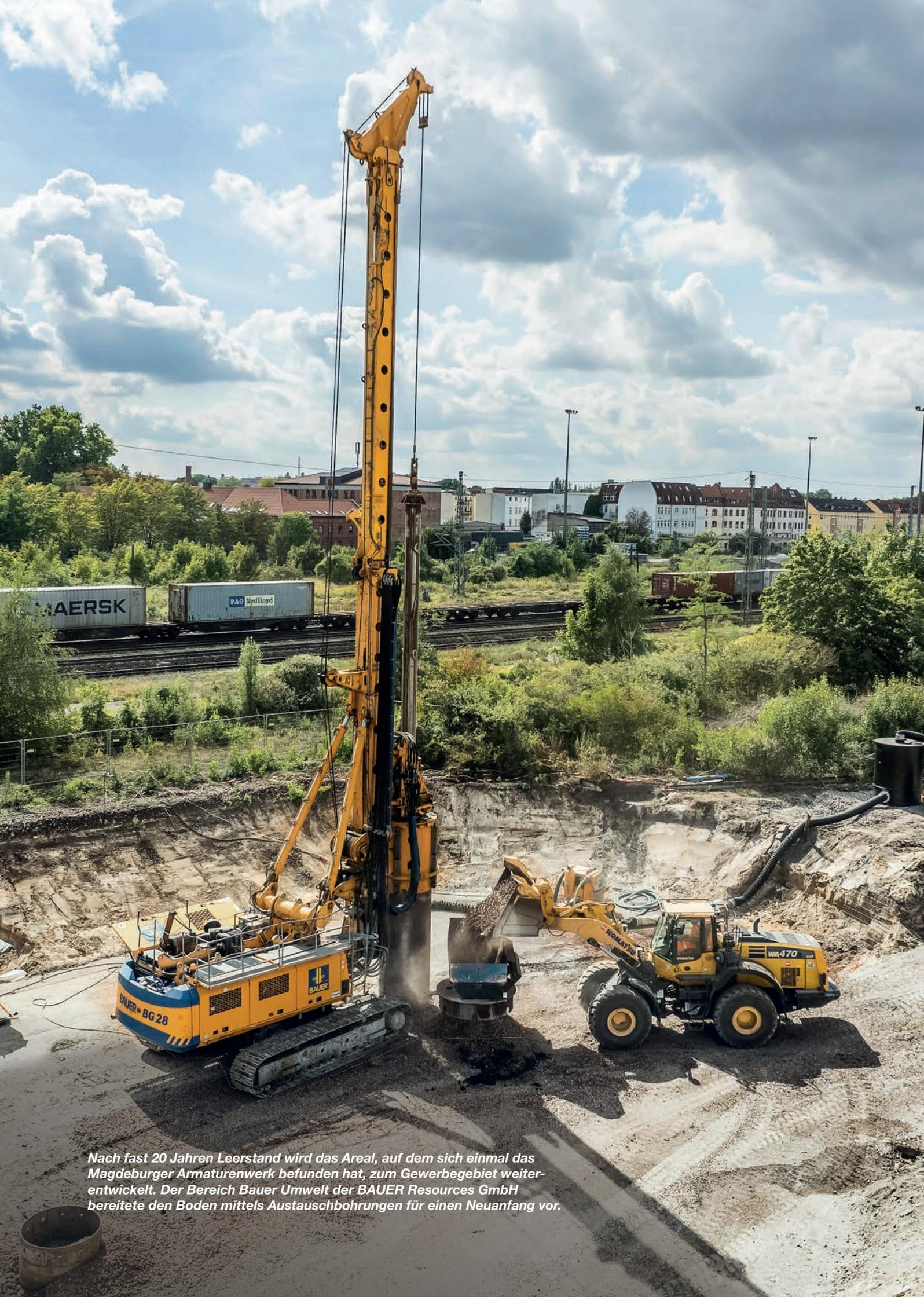
*Nach fast 20 Jahren Leerstand wird das Areal, auf dem sich einmal das Magdeburger Armaturenwerk befunden hat, zum Gewerbegebiet weiterentwickelt. Der Bereich Bauer Umwelt der BAUER Resources GmbH bereitete den Boden mittels Austauschbohrungen für einen Neuanfang vor.*
