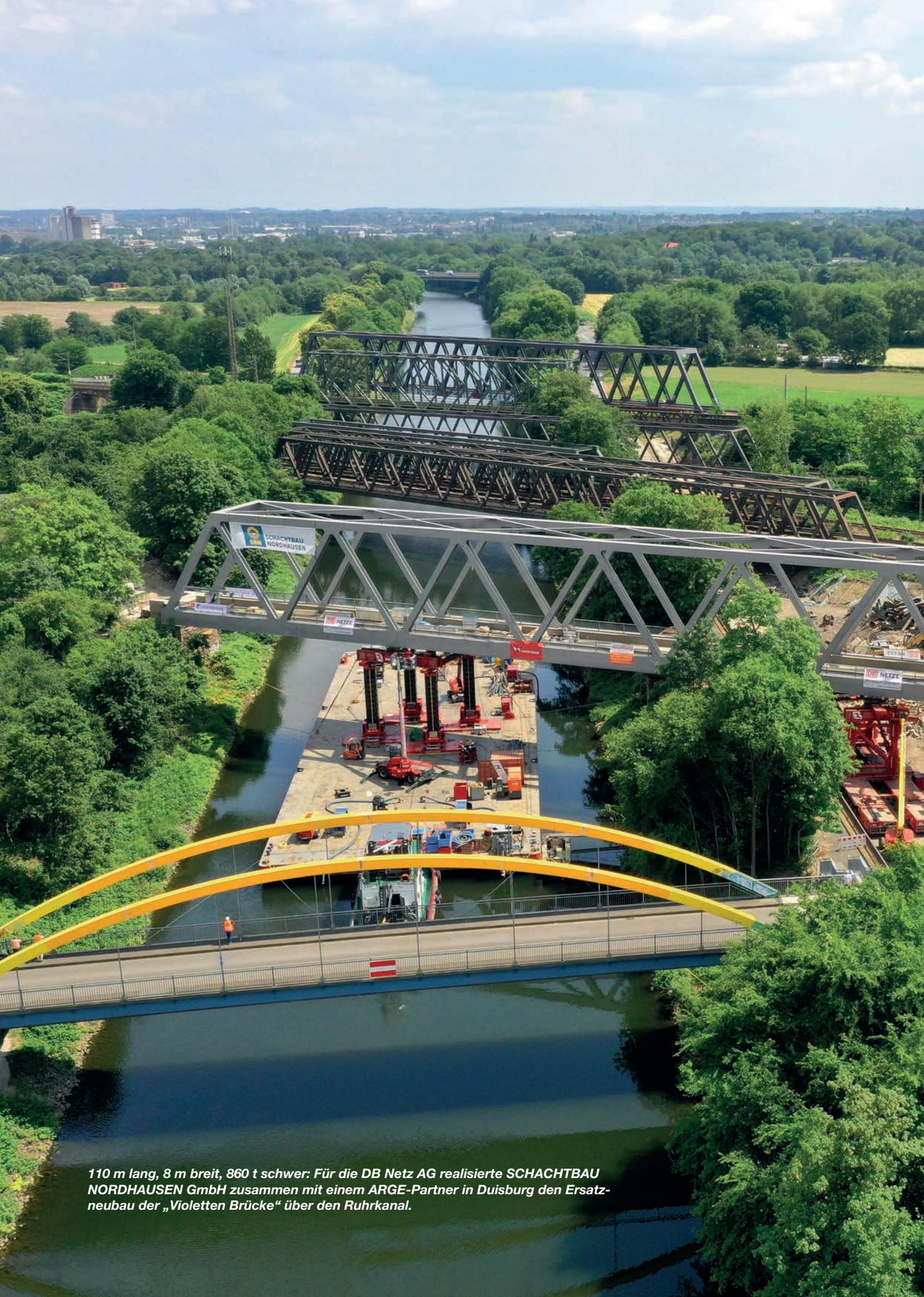
**110 m lang, 8 m breit, 860 t schwer: Für die DB Netz AG realisierte SCHACHTBAU NORDHAUSEN GmbH zusammen mit einem ARGE-Partner in Duisburg den Ersatzneubau der „Violetten Brücke“ über den Ruhrkanal.**
