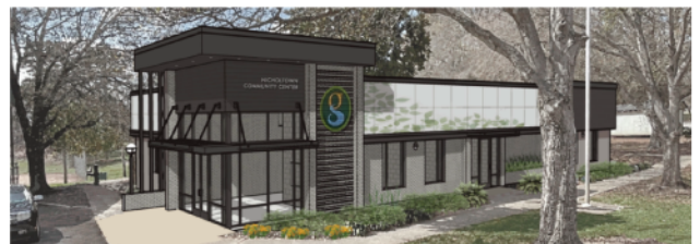
Un proyecto de $4.5 millones está en marcha para transformar el actual Centro Comunitario Nicholtown (arriba) en una instalación moderna (abajo).
