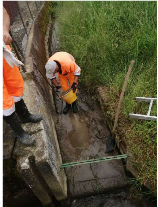
BOCCHETTO PIOVEGO TORREROSSA , stuccatura manufatto idraulico in via Cornoleo di Sotto in comune di Camisano Vicentino;
