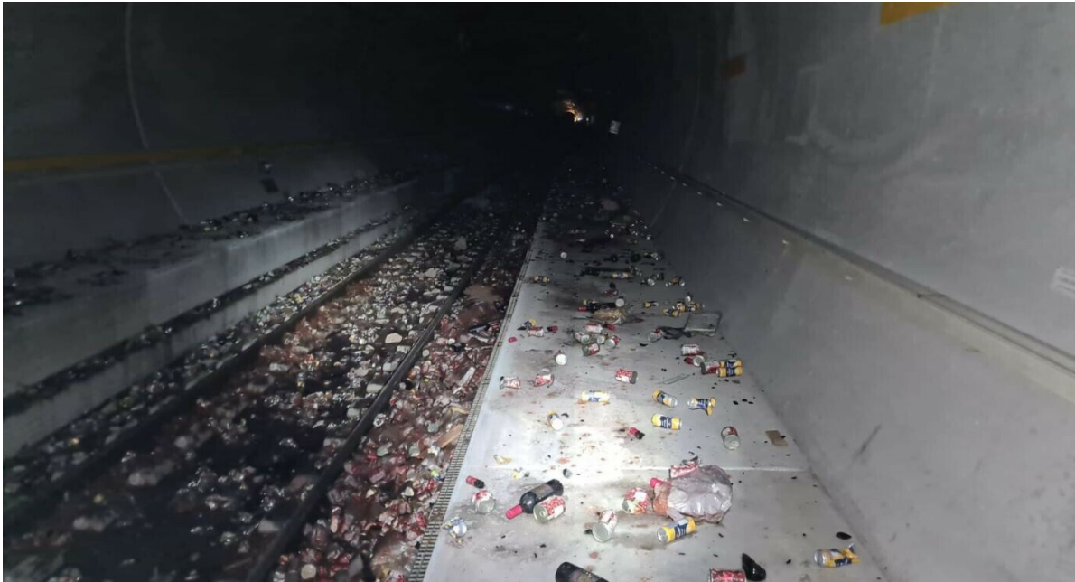
L'intero carico del vagone deragliato si è sparsa sulle rotaie e sulle rampe.
