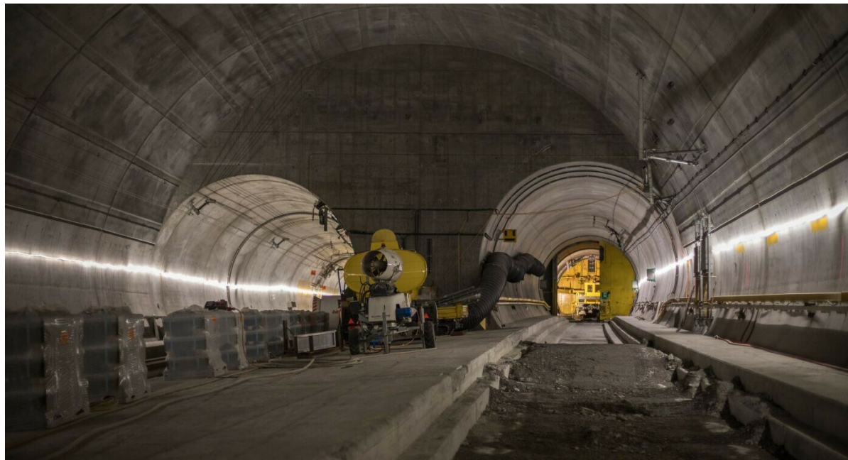
Nella stazione multifunzionale di Faido è già stato completamente rimosso il binario.
