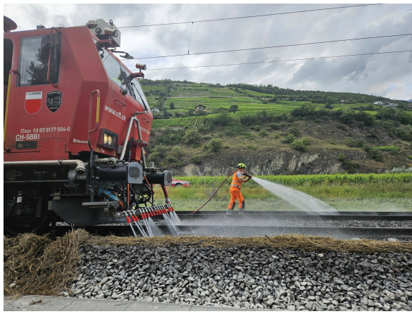
Travaux de déblaiement entre Martigny et Sierre/Siders
