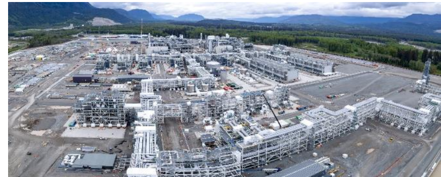
LNG CANADA EXPORT FACILITY // KITIMAT, B.C., CANADA
