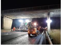
Les travaux consistent à retirer l'ancienne chaussée sur **3 à 17 cm de profondeur** avant d'appliquer une nouvelle couche de roulement sur les 3 voies de circulation et sur les bretelles du diffuseur de Bonnières (n°14). Au terme du chantier, les clients bénéficieront d'une autoroute lisse et uniforme pour une conduite plus agréable et sécurisée.
