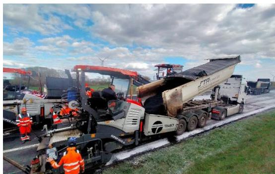
Les travaux consistent à retirer l'ancienne chaussée sur **4 cm de profondeur** en moyenne avant d'appliquer une nouvelle couche de roulement sur les 2 voies de circulation. Au terme du chantier, les clients bénéficieront d'une autoroute lisse et uniforme pour une conduite plus agréable et sécurisée.
