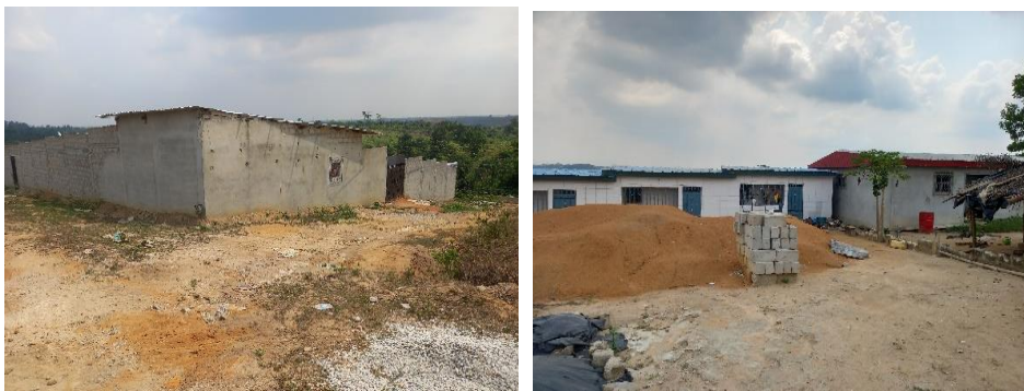
Photo 81 : Vue de quelques bâtis dans l'emprise du projet
