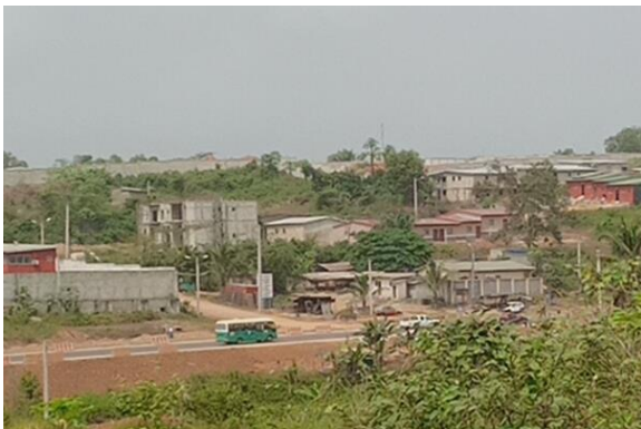
Photo 17 : Aperçu de quelques habitations riveraines au projet
