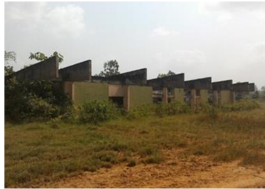
Photo 2: Vue des locaux de la RAN (Zone CAMA)
