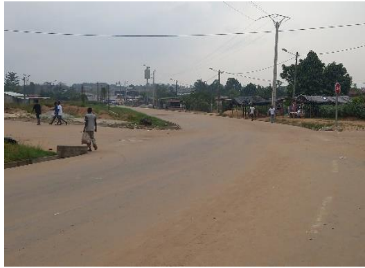
Photo 79 : Voirie de la voirie à Ahouabo
