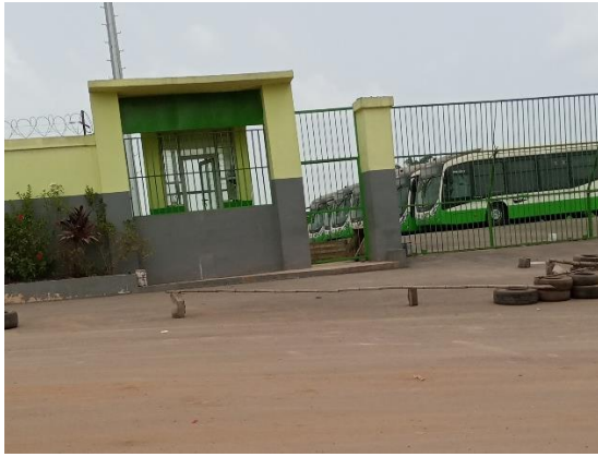
Photo 15 : Vue d'une gare SOTRA à proximité du site du projet
