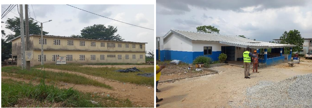
Photos 76 et 77 : Vue de l'établissement scolaire et du centre de santé d'Anyama Adjamé (Source : BNETD, Janvier 2023)
