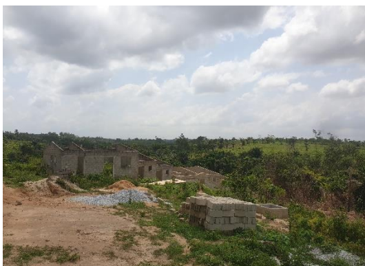
Photo 9 : Aperçu d'une maison en construction (Côté INSPV)
