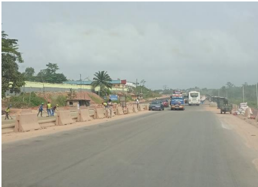
Photo 1 : Vue de la route Abidjan-Agboville
