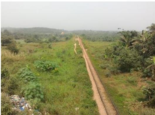
Photo 3 : Vue de la ligne du chemin de fer (Côté CAMA)
