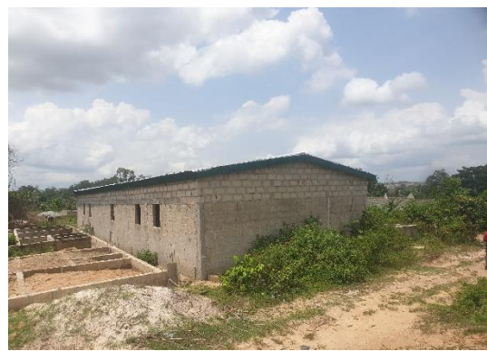
Photo 10: Nouvelle fondation et construction en finition (Zone INSPV)
