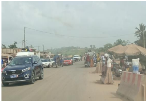
Photo 13 : Aperçu de l'Autoroute Abidjan-Agboville dans l'emprise du projet
