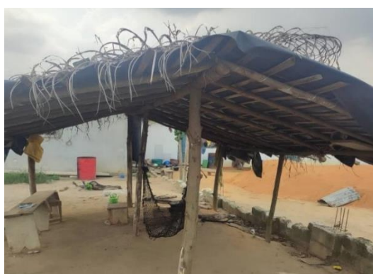
Photo 57: Charpente en Bambou et Acacia mangium
