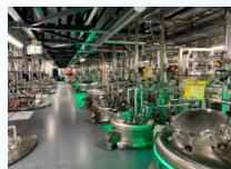
バイオ医薬品の製造現場
