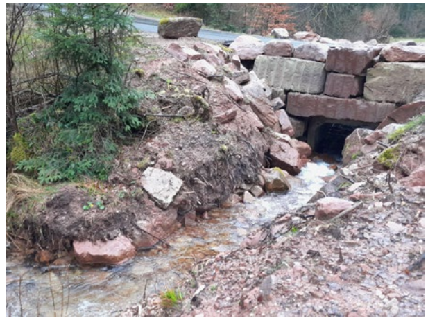
Le Hengstkessel en amont (après travaux) ©N.Gerard / ONF
