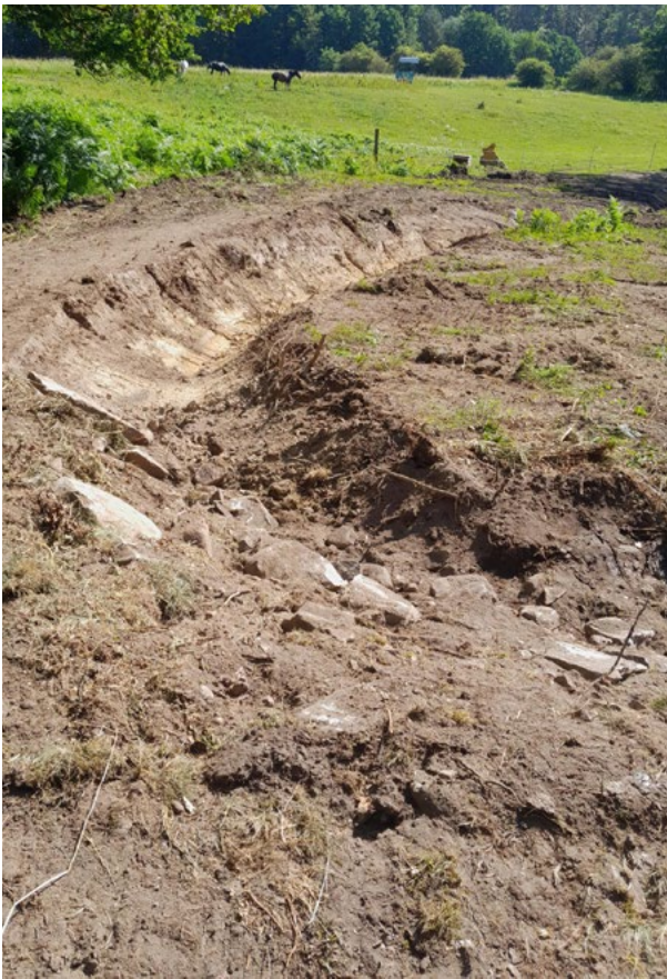
Reméandrage du lit du cours d'eau, avant mise en eau ©L.Colomb/ONF
