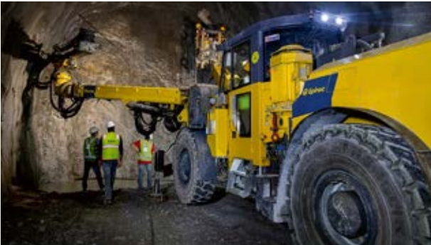
Arbetet med den 125 kilometer långa järnvägen Rishikesh-Karnaprayag i Himalaya är i full gång. Det nya projektet har en total tunnellängd på 218 kilometer. På plats finns Epirocs automatiserade och halvautomatiska maskiner, inkl. Boomer E2, som bidrar till ökad effektivitet och kortare cykeltid.
