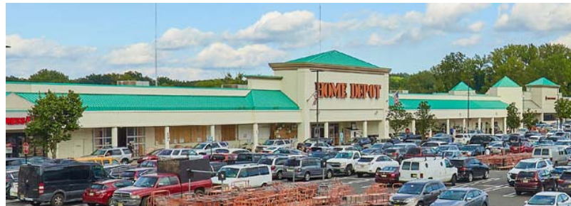
HACKENSACK COMMONS , Hackensack, NJ
